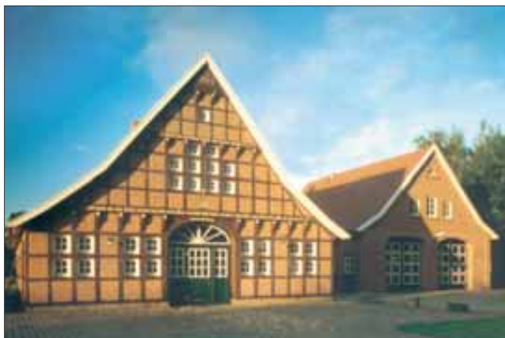
Gemeindehaus Wettrup mit Feuerwehrgerätehaus
